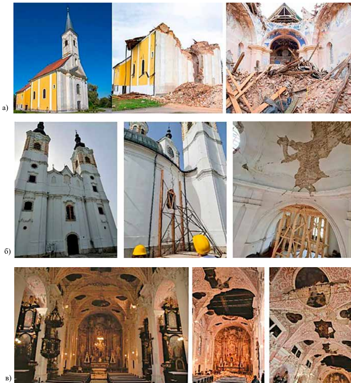
Сл. 10 Оштетувања на сакрални објекти, а) Црква Св. Никола и Св. Вид во Жажина, б) Црква Св. Марија Магдалена во Шишак, в) црква Св. Катерина во Загреб (земјотрес Загреб - лево, земјотрес Петриње – средина и десно), [31].
